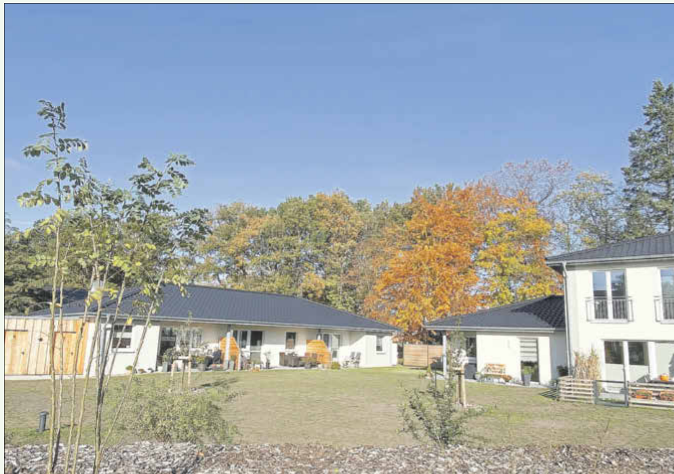
Neubau im Techentiner Weg 1a - h
