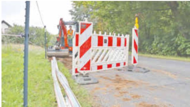
In mehreren Projektgebieten des Landkreises Ludwigslust-Parchim sind im vergangenen Jahr die Bauarbeiten gestartet – so wie hier in Gädebehn. Foto: WEMAG/Reiber
