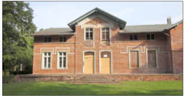
Schützenhaus vor den großen Sanierungsarbeiten
