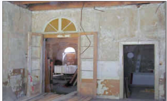
Räumlichkeiten während der Sanierungsmaßnahmen-bald im neuen Glanz
