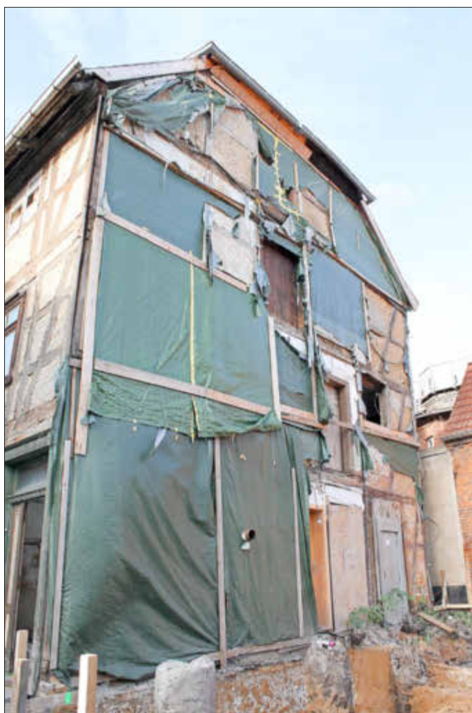
Die Giebelseite des erhaltenen Gebäudes nach dem Abriss der beiden Hinterhäuser.
