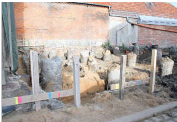
Zu sehen sind die noch ungekürzten Pfahlköpfe.
