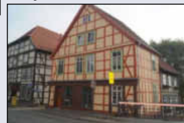
2016 - Sanierung Wachtstr. 1 und Eröffnung Kundencenter Stadtwerke
