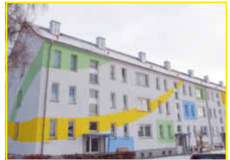
Kremminer Straße nach der Sanierung
