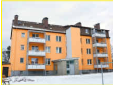
Goethestraße nach der Sanierung
